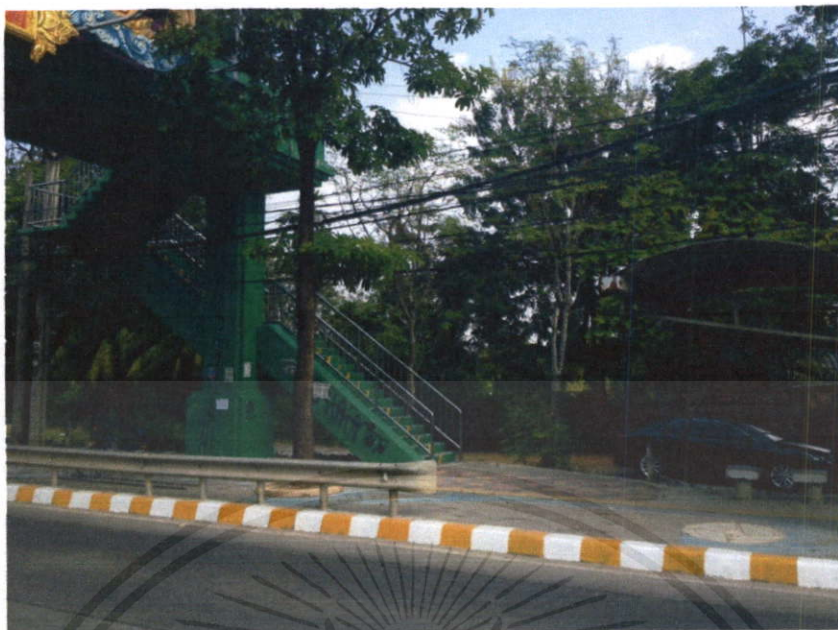
ภาพที่ 3.14 ภาพถ่ายสิ่งอำนวยความสะดวกการเข้าถึงด้านหน้าโครงการ ที่มา : ภาพถ่ายจากการลงพื้นที่สำรวจที่ตั้งโครงการ
