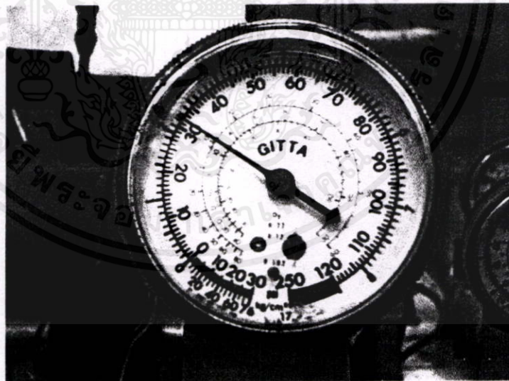
รูปที่ 4.5 แสดงค่าแรงดันของสารทำความเย็นที่อีแวปโปเรเตอร์
