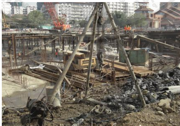
ภาพที่ 2.5 การเจาะเสาเข็มขนาดใหญ่ (ที่มา: ภควัด รักศรี,2557 ) มีการนำไปใช้
