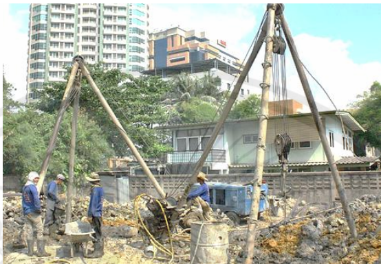
ภาพที่ 2.4 การเจาะเสาเข็มขนาดเล็กแบบระบบแห้ง (ที่มา: ภควัด รักศรี,2557 )
