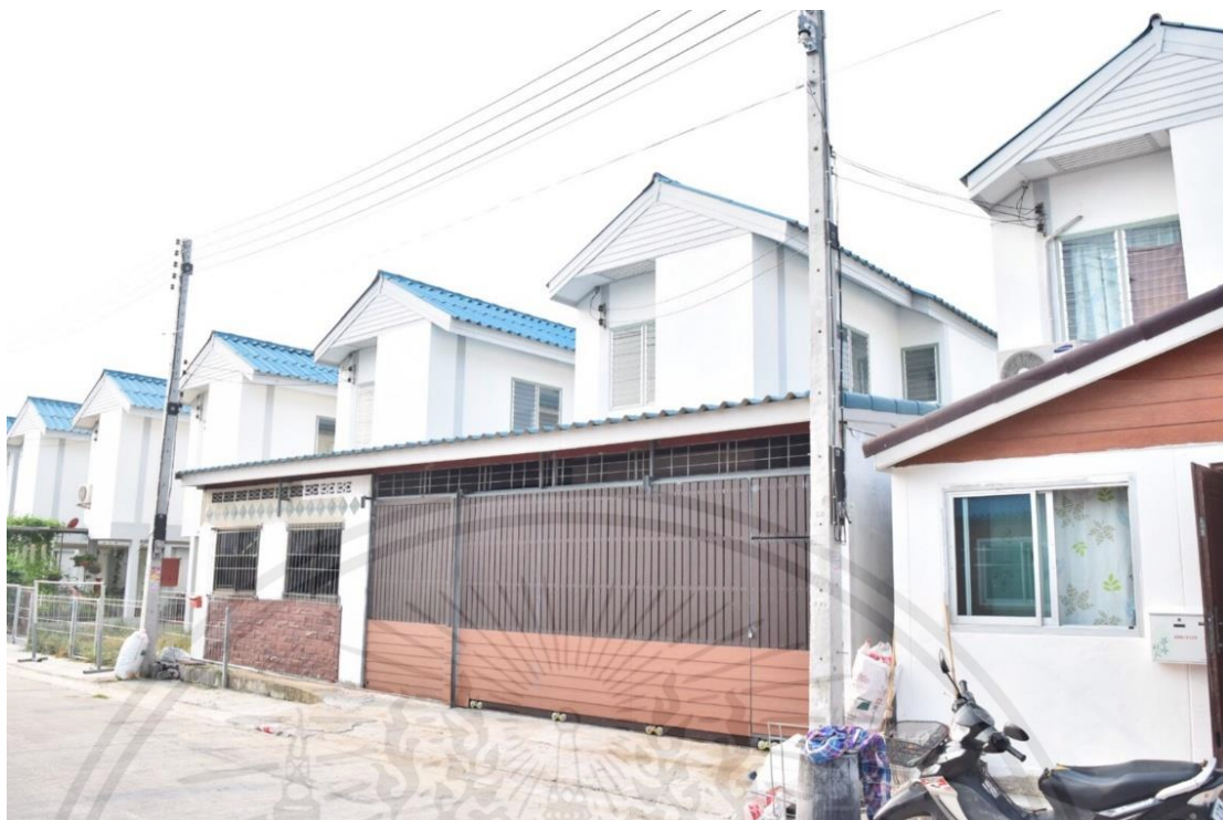
รูปที่ 2.42 บ้านในโครงการเอื้ออาทรที่เกิดลักษณะการต่อเติม (ที่มา : โครงการเอื้ออาทร สระบุรี (บ้านนา-แก่งคอย) )
