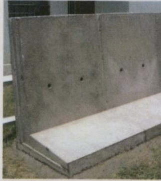
รูป 2.13 กำแพงกันดิน Cantilever Wall [บรรณาธิการเว็บไซต์บ้านและสวน ,2557]
