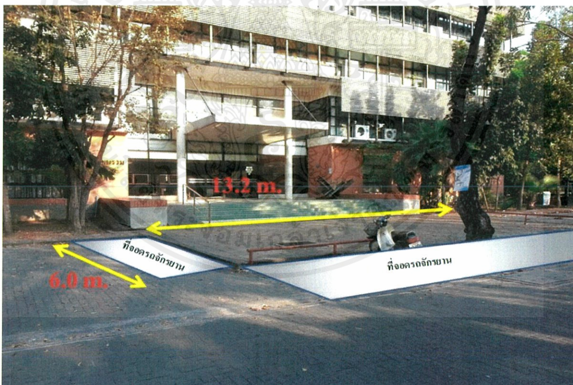
รูปที่ 4.56 พื้นที่จอดรถจักรยานหน้าอาคารเรียนรวม
