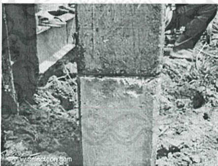
รูปที่ 4.6 การเชื่อมเสาต้นที่สองและเสาต้นที่หนึ่ง
