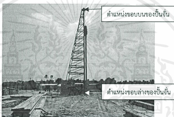
รูปที่ 3.4 ภาพบันจันความสูง 18 เมตร ขณะทำการตอกเสาเข็ม
