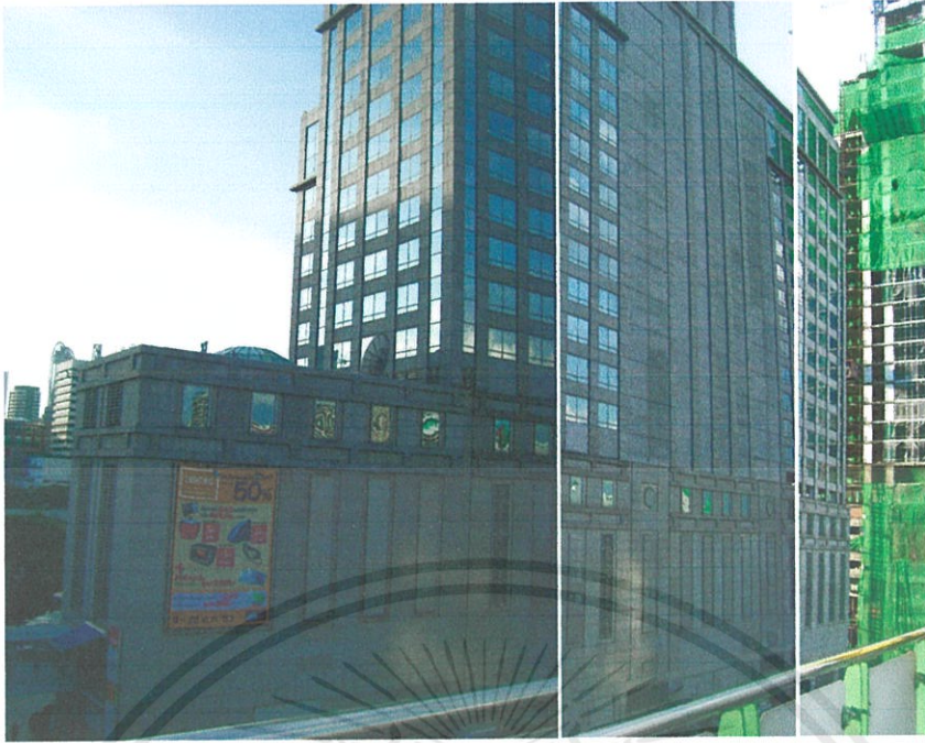
รูปที่ 5- 20 อาคารเวฟ เฟลส ถนนวิทยุ
