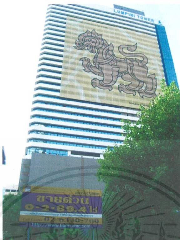
รูปที่ 5- 28 อาคารลุมพินีทาวเวอร์
