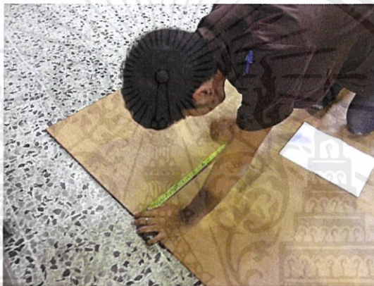
รูปที่ 3.16 ทำการตีเส้นและวัดขนาดไม้อัด
