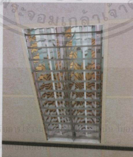
ภาพที่ 4.1 โคมไฟฝังฝ้า/สะท้อนแสง/ตะแกรงและหลอดไฟฟลูออเรสเซนต์(T5)
