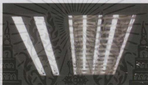
ภาพที่ 2.7 การเปรียบเทียบรูปการจจัดวางโคมหลอด T5 และ โคมหลอด T8 ในพื้นที่สำนักงาน
