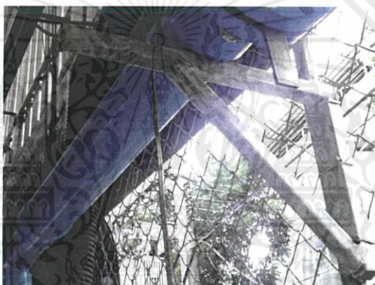
รูปที่ 4.11 ตำแหน่งรองรับท่ออากาศ
