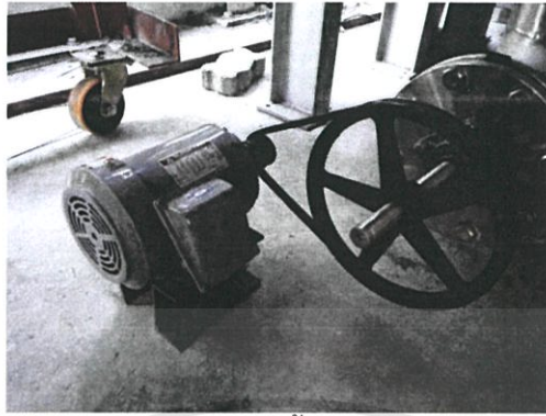
รูปที่ 4.6 มอเตอร์หลังการติดตั้งเข้ากับสกรูระบายเถ้าหนัก
