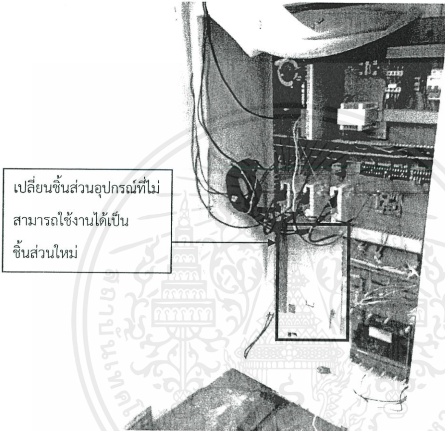
รูปที่ 3.3 ชิ้นส่วนอุปกรณ์ที่ไม่สามารถใช้งานได้ (แผงซีพียู)
