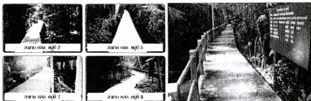
ภาพที่ 4.3 แสดงสะพานทางเดินเท้ายกระดับ คสล. ในพื้นที่ตำบลบางกะเจ้า ที่มา: จากการสำรวจเดือนมกราคม พ.ศ. 2553
