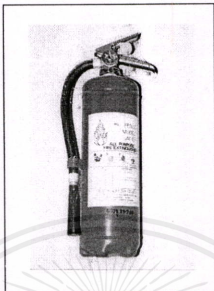
ภาพที่ 2.22 แสดงเครื่องดับเพลิง ติดบริเวณผนังของโรงฝึกงาน ใช้ในการดับเพลิงในกรณีที่มีเพลิงไหม้ในโรงฝึกงาน เป็นอุปกรณ์ที่มีความจำเป็นในการรักษาความปลอดภัยของโรงฝึกงาน
