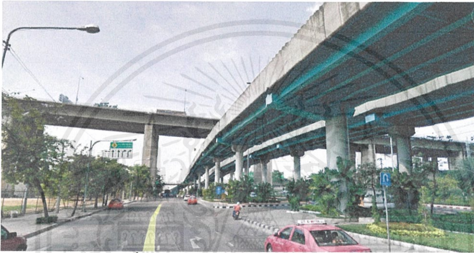
รูปที่ 6-6 แสดงถนนบริเวณหน้าโครงการ
