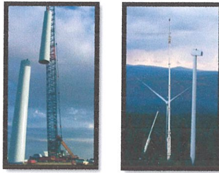
รูปที่ 2.33 แสดงเครื่องจักรและอุปกรณ์ขนย้ายและติดตั้งกังหันลม
