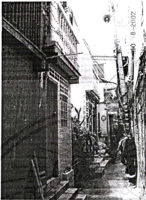
ภาพที่ 4.13 สภาพทางเดินคอนกรีตภายในชุมชน
