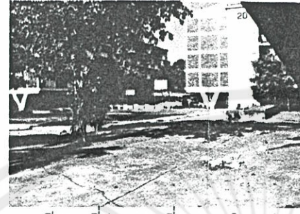
ลานกีฬา-ที่ว่างและที่จอดรถในแฟลตห้วยขวาง
