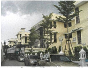
ภาพถ่ายเข้าจากทางด้านหลังอาคาร
