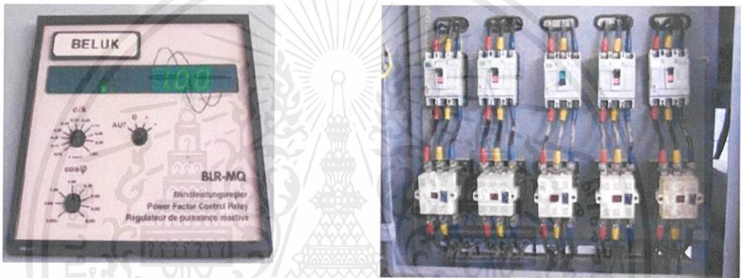
รูปที่ 2.3 ตัวควบคุมค่าตัวประกอบกำลังไฟฟ้าอัตโนมัติและอุปกรณ์ตัดต่อชุดตัวเก็บประจุ (ที่มา : การแก้ไขค่าตัวประกอบกำลังไฟฟ้ากองทุนส่งเสริมเพื่อการอนุรักษ์พลังงาน สำนักงานคณะกรรมการนโยบายพลังงานแห่งชาติ)
