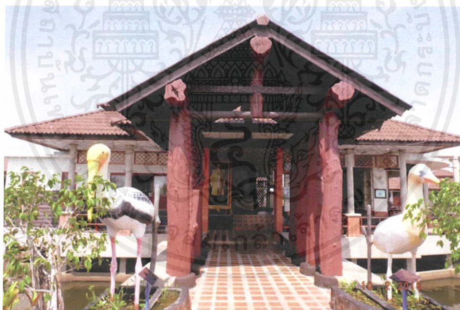
รูปที่3.24 อาคารสำนักงาน
