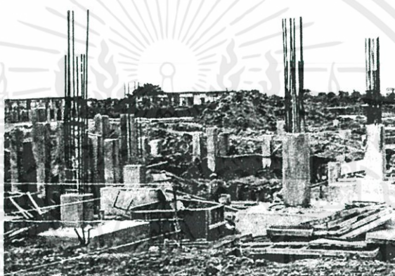
รูปภาพที่ 7.1 แสดง วิธีการก่อสร้างของระบบโครงสร้างหล่อในที่
