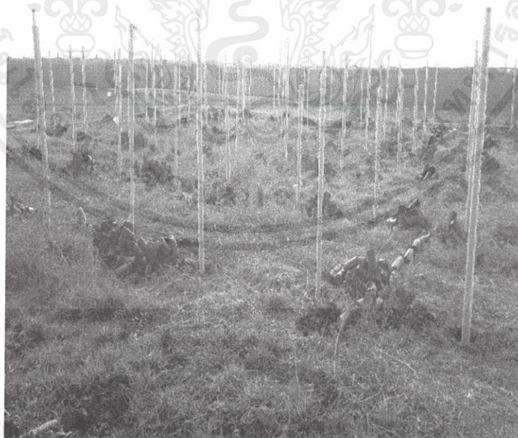
รูปที่ 3.21 ผังแสดงการติดตั้งท่อระบายน้ำแนวดิ่ง
