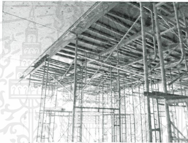
รูปที่ 3.18 แสดงการติดตั้งนั่งร้าน เมื่อแล้วเสร็จ
