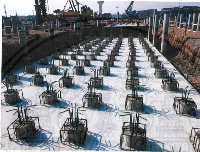
รูปที่ ผ.ง.1 หัวเข็มฐานรากและเมื่อเท lean คอนกรีตเสร็จ
