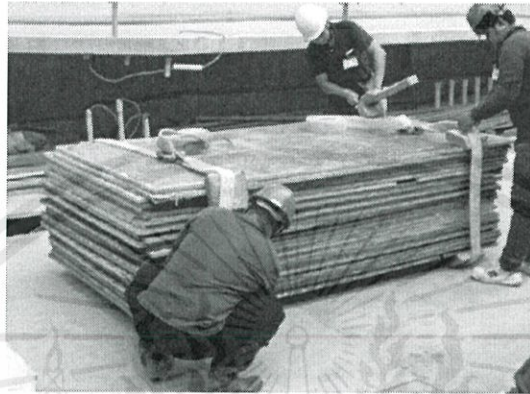
รูปที่ 3.13 แผ่นไม้แบบที่ใช้ปูบนนั่งร้าน
