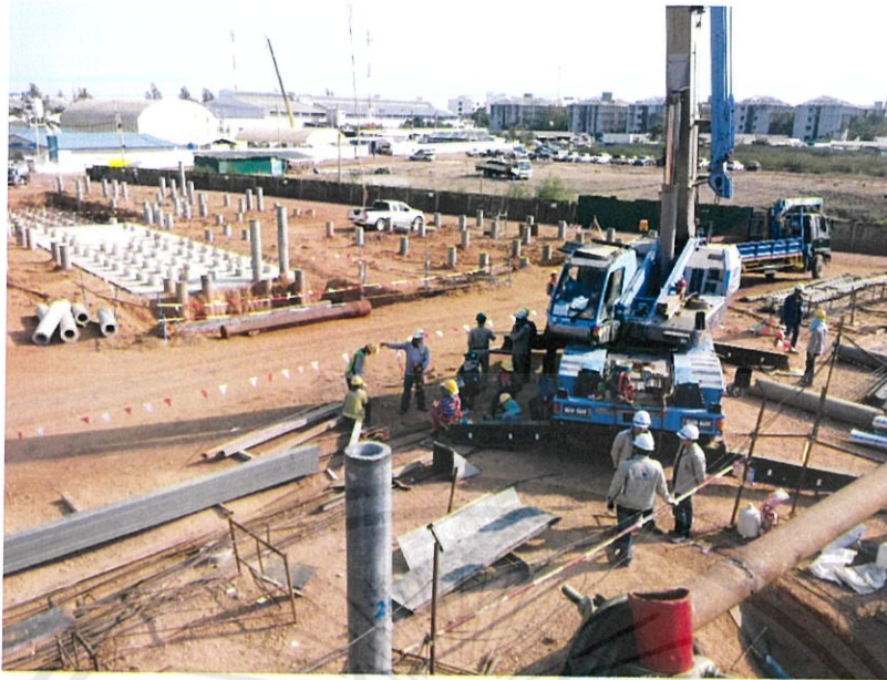
รูปที่ ผ.ง.5 บริเวณโดยรอบเขตการก่อสร้าง
