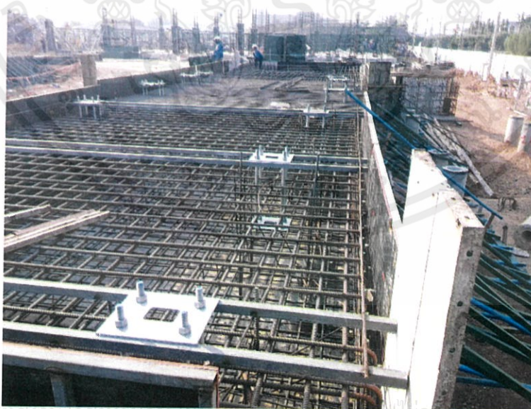
รูปที่ ผ.ง.2 ตัวฐานรากเมื่อพร้อมเทคอนกรีต
