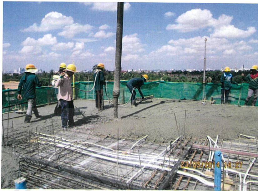
รูปที่ ผ.ง.7 การเทคอนกรีตลงในแบบพื้น
