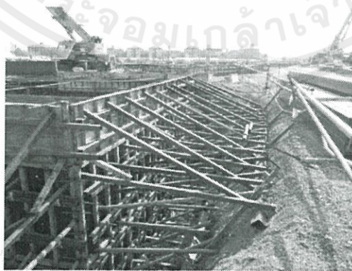
รูปที่ 3.3 การค้ำยันแบบหล่อฐานราก
