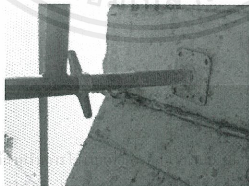
รูปที่ 3.12 อุปกรณ์ jack base ที่ค้ำยันกับผนัง
