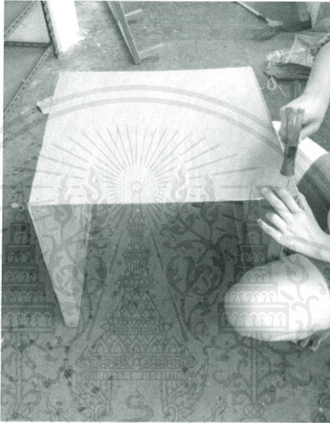
รูปที่ 4.21 แสดงการติดไม้อัดเข้ากับโครงหน้าตัดห้องอบแห้ง
