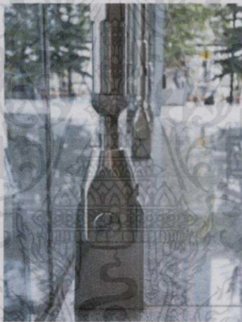
ภาพที่ 4.38 แสดงรอยต่อโครงเคร่า Curtain wall กับ พื้นโครงสร้าง
