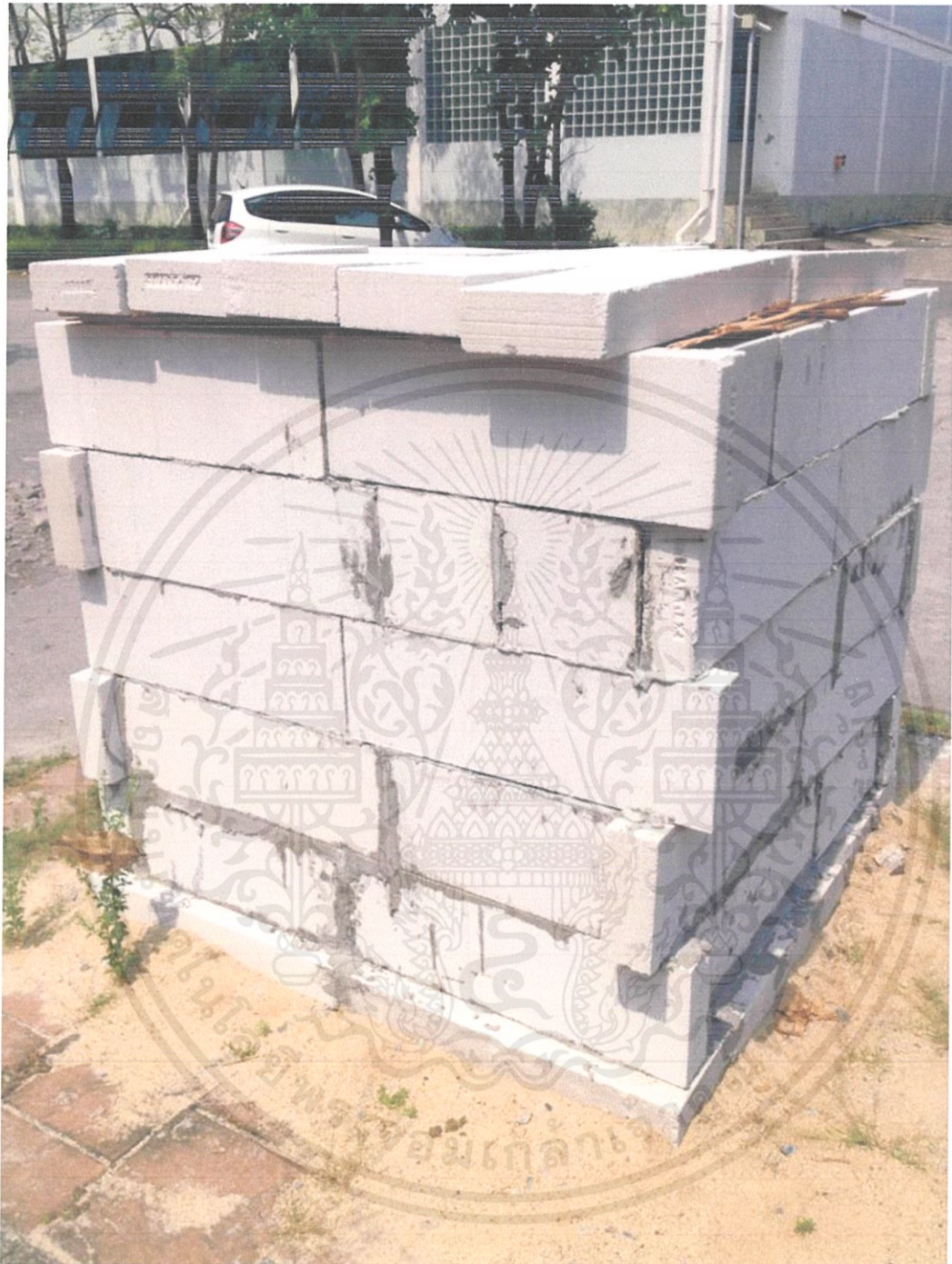
รูปที่ 3.14. ห้องขนาด 1 ลูกบาศก์เมตร ด้วยอิฐมวลเบาตอนสมบูรณ์
