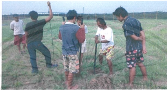
รูปที่ 3.32 ภาพการใช้พลั่วในการขุดนำก่อนที่จะทำการฝังท่อแนวตั้ง
