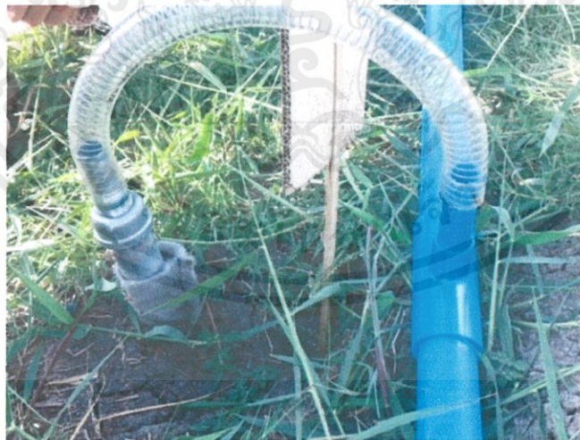
รูปที่ 3.36 ภาพแสดงการวางท่อแนวนอน (Horizontal Drains)
