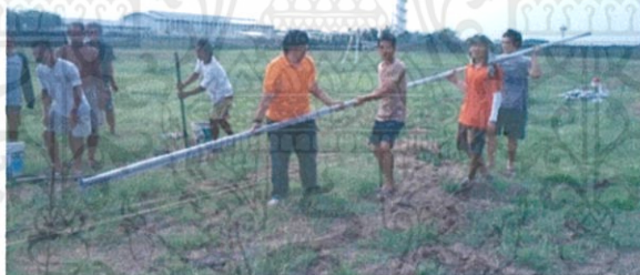
รูปที่ 3.33 ภาพท่อเหล็กที่ทำการสวม Geotextile แล้ว
