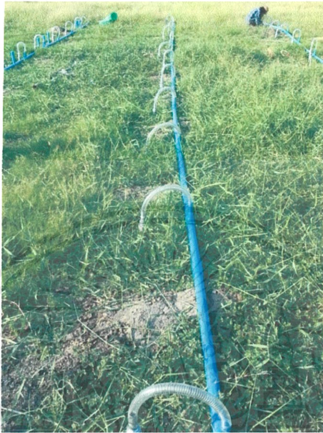
รูปที่ 3.36 ภาพแสดงการวางท่อแนวนอน (Horizontal Drains)
