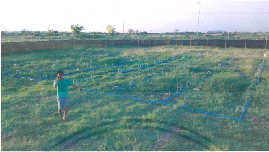
รูปที่ 3.38 ภาพแสดงพื้นที่ที่ทดลองหลังจากติดตั้งวางแนวท่อเสร็จแล้ว
