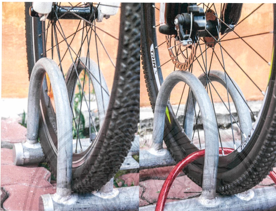
ภาพที่ 3.29 ภาพความสูงของที่จอดที่ไม่ชน Disc Brake ของจักรยาน
