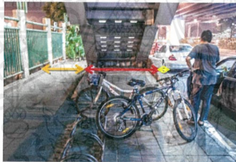
ส่วนสีแดง (ความกว้างบันได) มีระยะ 2200mm ส่วนสีส้ม (ความกว้างทางเดิน) มีระยะ 1800mm ส่วนสีเหลือง (ความกว้างขอบทางเท้า) มีระยะ 500mm
