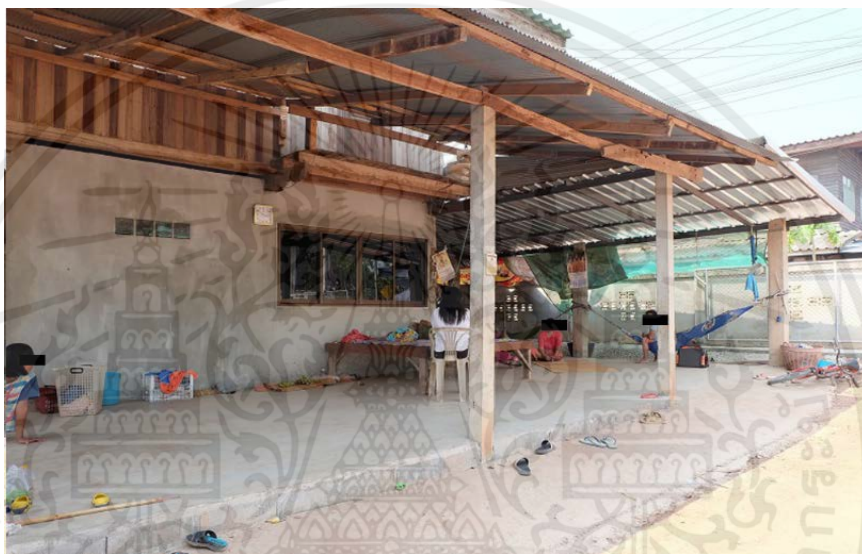
ที่มา : ภาพถ่ายลงสำรวจพื้นที่กรณีศึกษา (ครั้งที่ 3) ปี 2562
