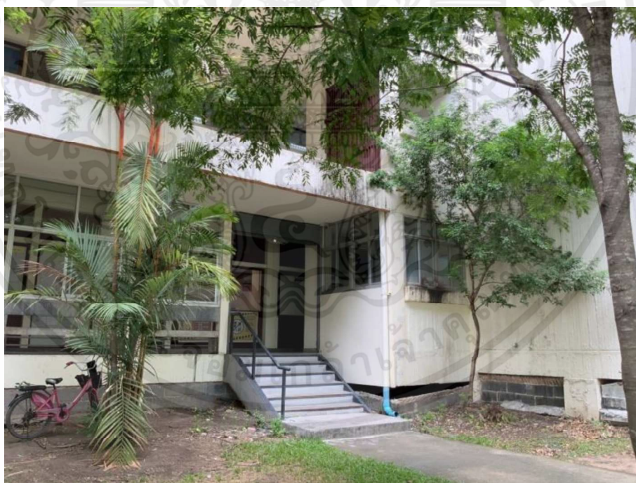
รูปที่ 4.20 ด้านหลังอาคารเรียนคณะวิศวกรรมศาสตร์ (ที่มา : ผู้วิจัย)
