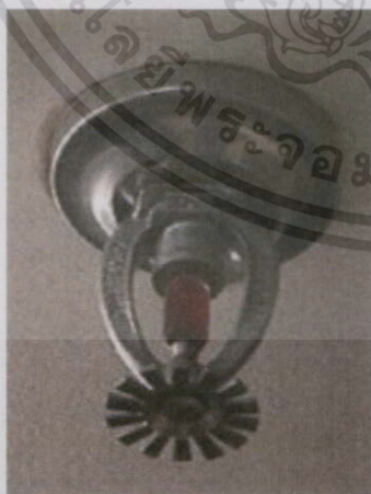
ภาพที่ 6-16 ระบบใช้น้ำดับเพลิง อัตโนมัติแบบฉีดน้ำฝอย
