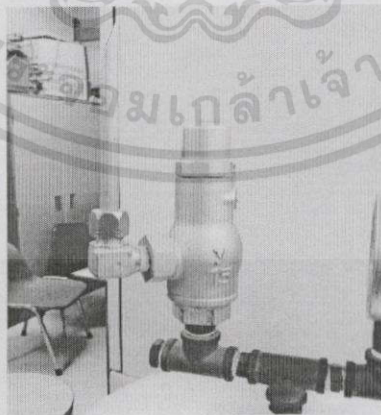
รูปที่ 3.30 แสดง Relief Valve
