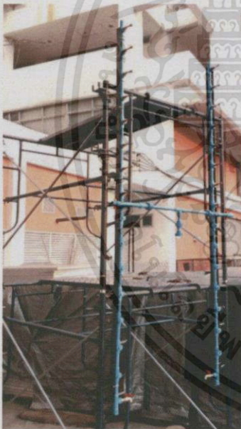
รูปที่ 5 การออกแบบและประกอบสร้างแนวหัวพ่นน้ำ
