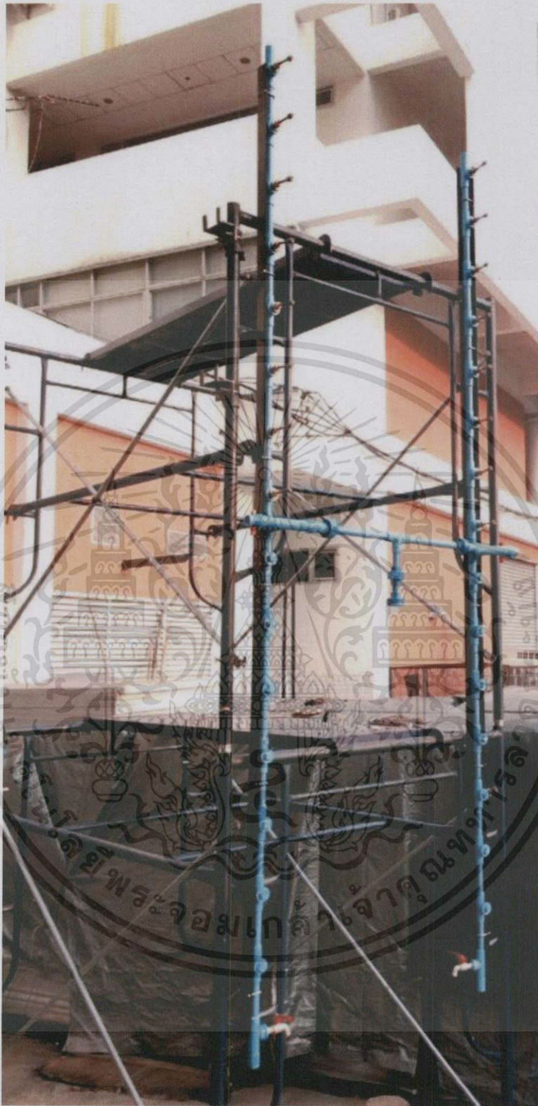
รูปที่ 3.16 แนวหัวพ่นน้ำยึดกับเหล็กฉากรับแรงโดยแขวนบนนั่งร้านด้วยยูโบลต์แนวเฉียง
