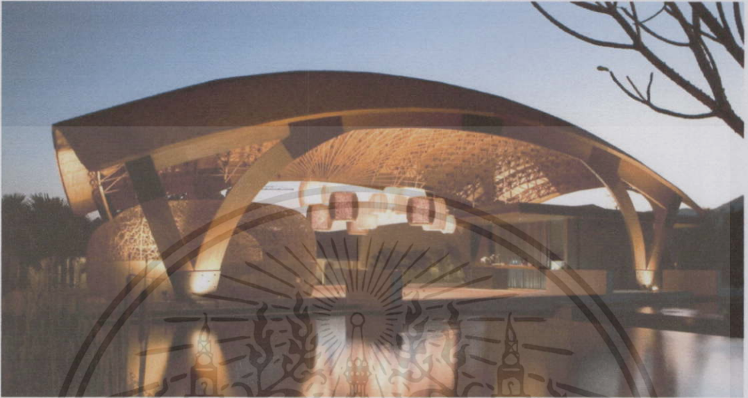
รูปที่ 4.7 แสดงโครงสร้างอาคารของส่วนลอบบี้ (ที่มา : Resort by Thai Architect. Serene modernity. Bangkok : Li-zenn Publishing Limited, 2011.)
