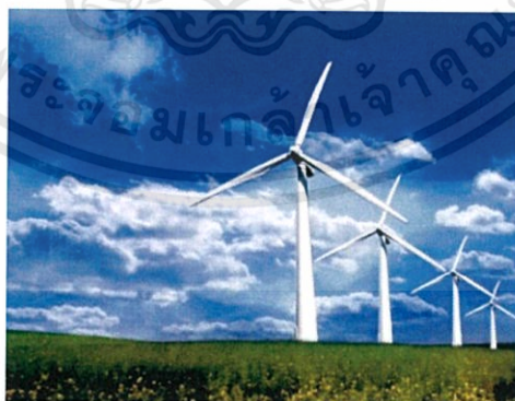
รูปที่ 2.8 กังหันลมผลิตไฟฟ้าแบบแกนนอน
