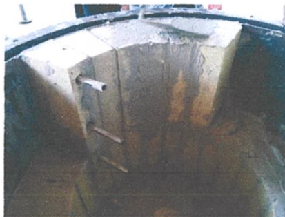
รูปที่ 4.7 ชั้นก่ออิฐชั้นที่สอง
