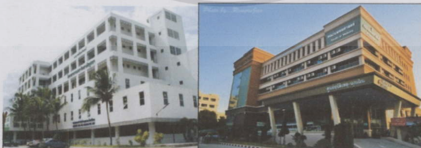
ภาพถ่ายสิ่งปลูกสร้างบริเวณทิศตะวันตกของโครงการ
