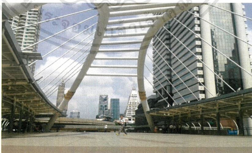
ภาพที่3.1 ภาพถ่ายสถานที่ สะพานรถไฟฟ้า BTS สาทร
