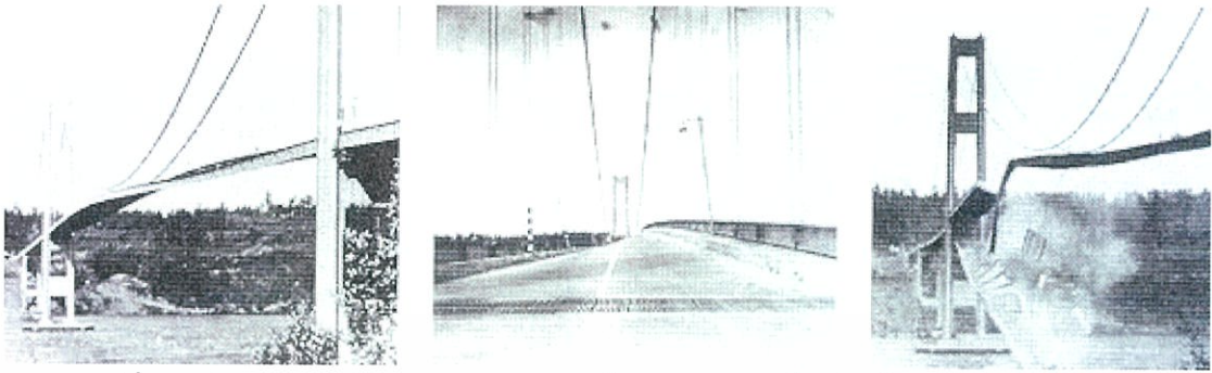
รูปที่ 2.10 การพังของสะพาน Tacoma Narrow เป็นผลมาจากการสั่นพ้องเนื่องจากมีลมพัดอย่างแรงพอดีกับจังหวะการสั่นของสะพานพอดี
