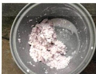
ภาพประกอบที่ 41 : นำกระดาษที่บีบน้ำผสมกับกาวลาเท็กซ์ จากนั้นใส่ถุงปิดให้มิด ทิ้งไว้เพื่อนำไปประกบกับโครงสร้าง
