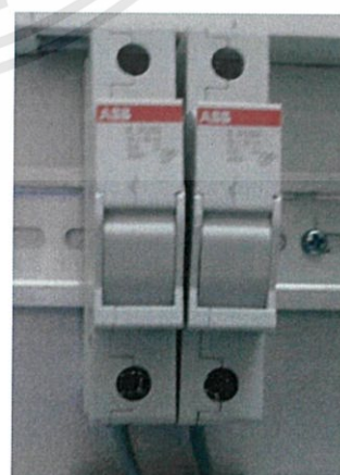
รูปที่ 3.8 ฟิวส์ (a) ฟิวส์ไบเมทัล NH00C (b) ฟิวส์ขนาดพิกัดกระแส 6 A
