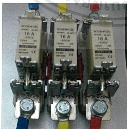
รูปที่ 3.8 ฟิวส์ (a) ฟิวส์ไบเมทัล NH00C (b) ฟิวส์ขนาดพิกัดกระแส 6 A
