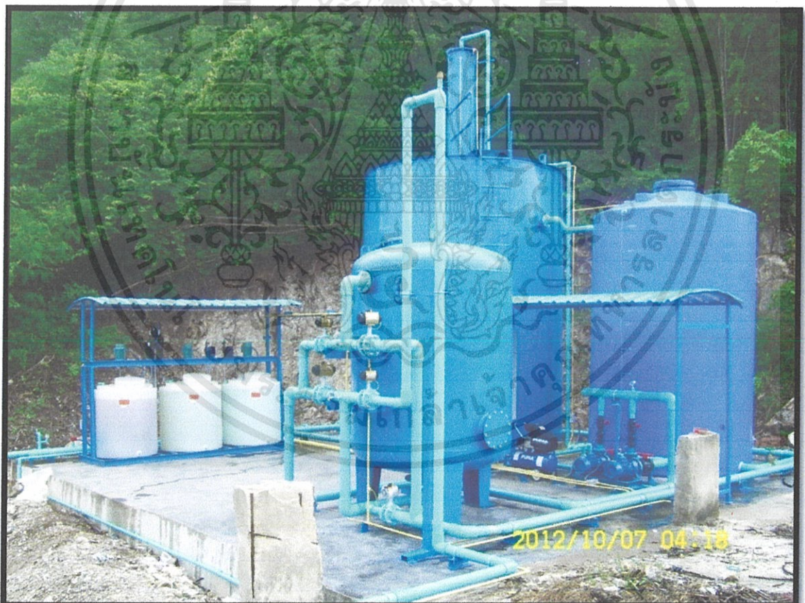
รูปที่ จ-4 รูปภาพจริงของระบบตกตะกอนแบบพัลเซเตอร์ ชนิดสูญญากาศ
