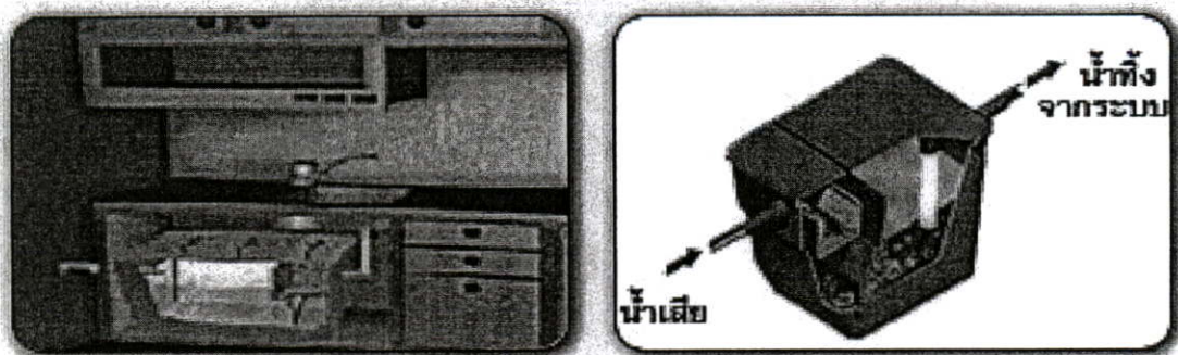
ภาพที่ 2.27 แสดงการติดตั้งบ่อดักไขมันภายในอาคารบ้านเรือน ภัตตาคาร และรูปตัดของบ่อ
