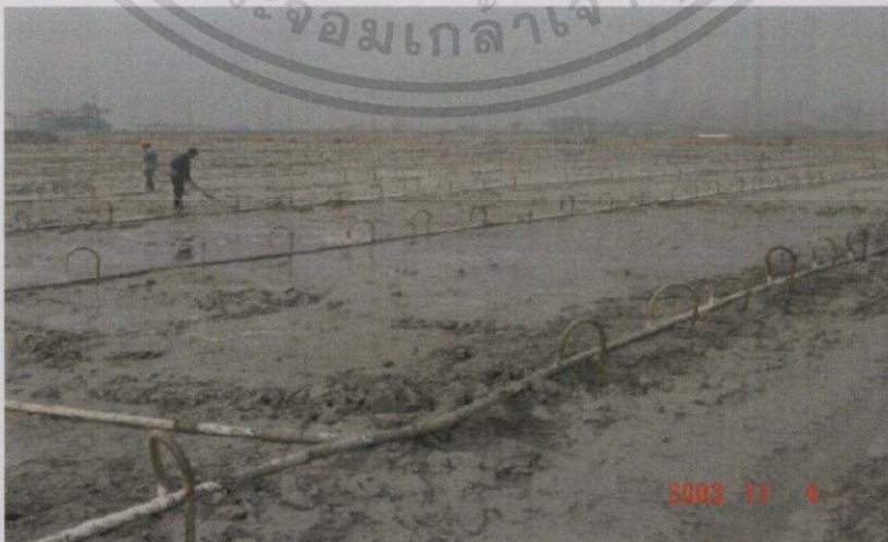
รูปที่ 2.5 แถวของท่อสุญญากาศและท่อระบายน้ำในแนวราบ (R. Y. Liang, and S. Xu. ; 2010)
