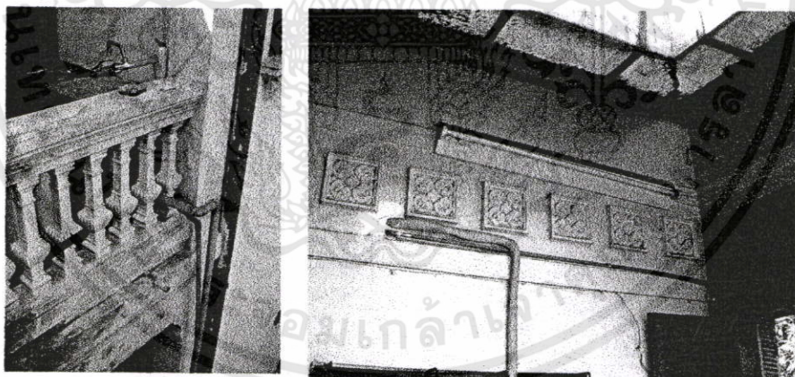
ภาพที่ 4.15 การเดินท่อที่ไม่มีระเบียบที่อาคาร 21
