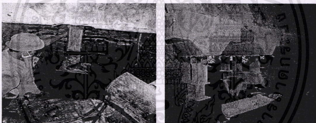
ภาพที่ 2.86 การตอกเสาเข็มด้วยปั้นจั่นไฮดรอลิก
