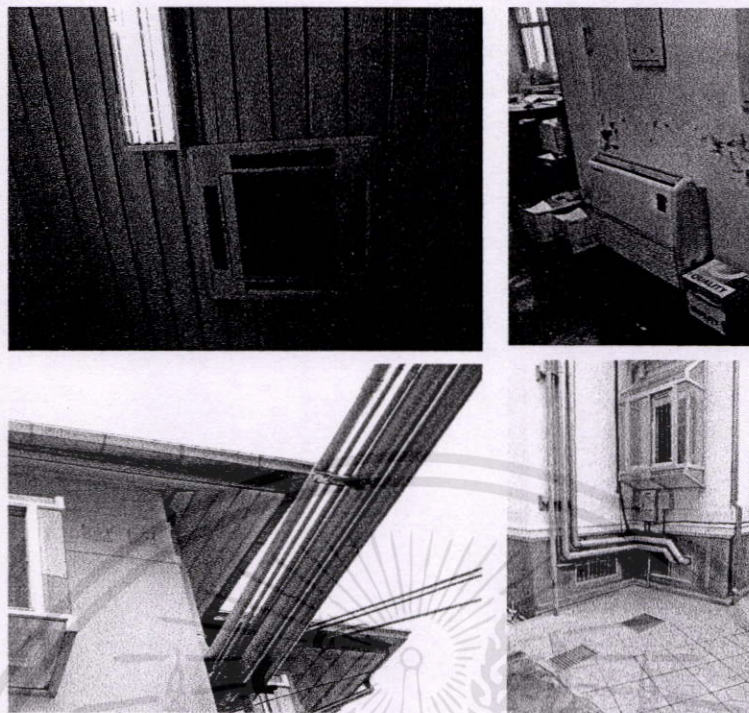
ภาพที่ 2.76 การติดตั้งระบบปรับอากาศ
