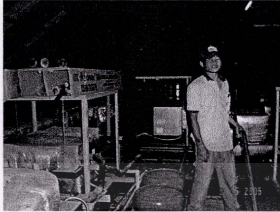
ภาพที่ 2.30 การติดตั้งก่อนนำความเย็นได้หลังคา
