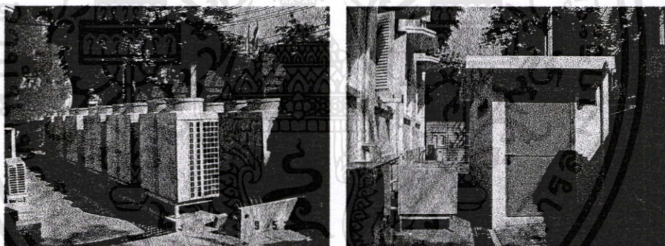
ภาพที่ 4.94 การติดตั้งส่วนทำความเย็นห่างจากอาคาร
