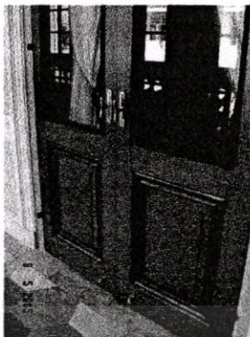
ภาพที่ 4.82 การใส่ลูกฟักกระจกแทนลูกฟักไม้
