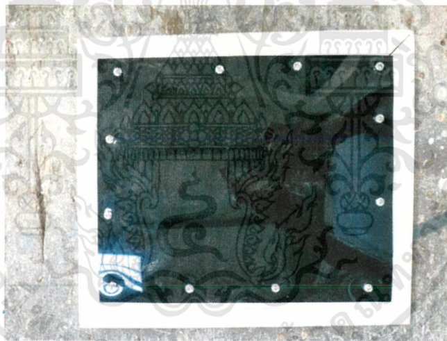
ภาพที่ นำแผ่นอะคริลิกที่เจาะรูไว้มาวางลงบน โครงสร้างไม้ เพื่อยึดเนื้อให้แผ่นอะคริลิกยึดติดกับ โครงสร้างของไม้
