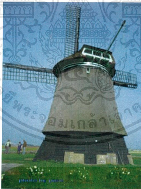
รูปที่ 2.1 กังหันสำหรับสูบน้ำในประเทศฮอลแลนด์
