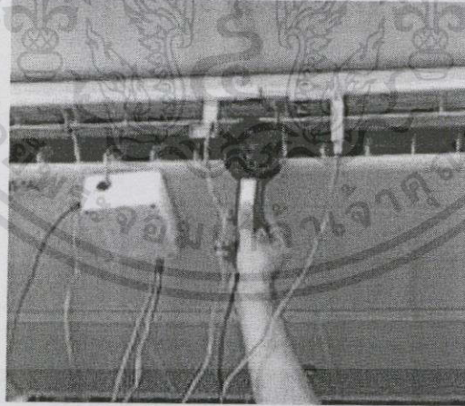
รูปที่ 2.5 การวัดความเร็วลมด้านช่องลมจ่ายของเครื่องปรับอากาศ
