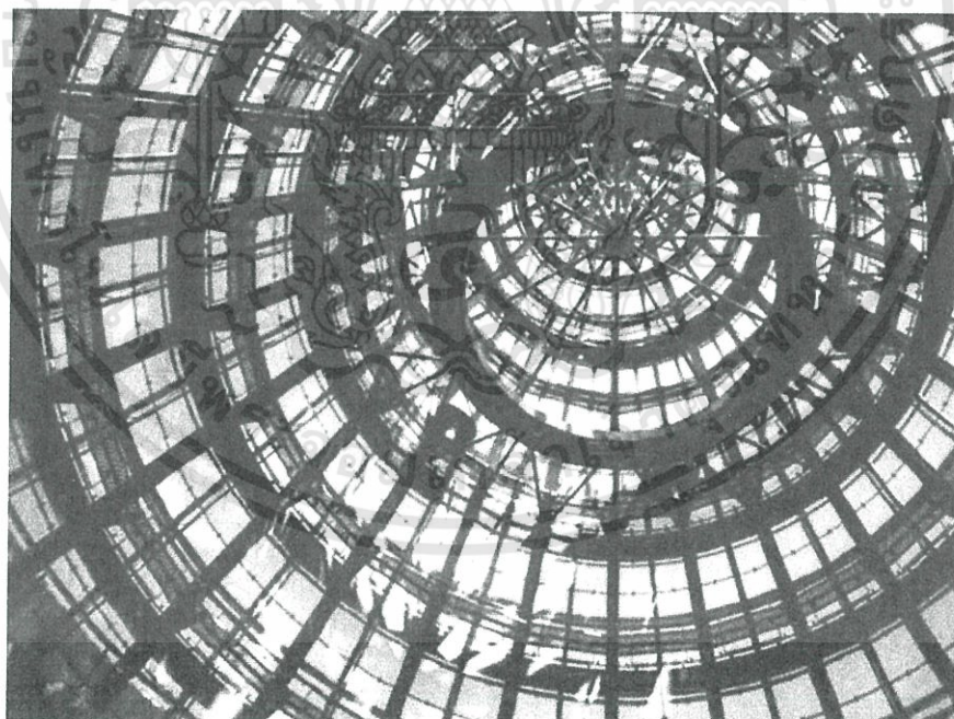
รูปที่ 3.56 แสดง โครงสร้าง โถงหลัก มีลักษณะเป็นรูปทรงกรวยของอาคารซึ่ง มีทางลาดขึ้นไปยัง ส่วนจัดแสดงนิทรรศการในชั้นต่างๆ
