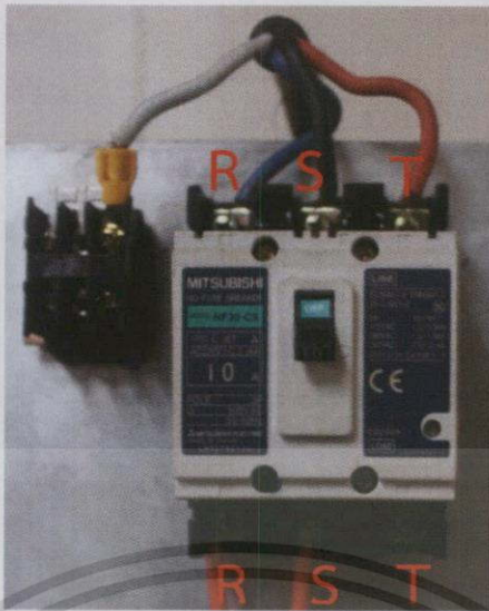
รูปที่ 4.14 แหล่งจ่ายไฟแรงดัน 380 โวลต์
