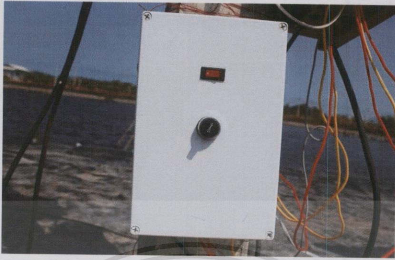
รูปที่ 4.26 การติดตั้งส่วนเอาต์พุตของระบบตัวที่ 1
